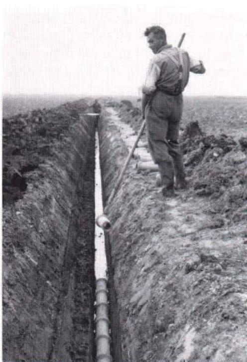
手作業による暗渠パイプの敷設
