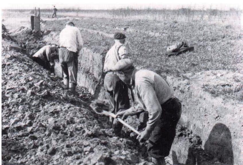
深く掘って地表層の砂土を深層の粘土でカバーする
